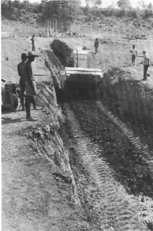
Construction d'un barrage à Diebouougou et barrage de Tensobetenga.
