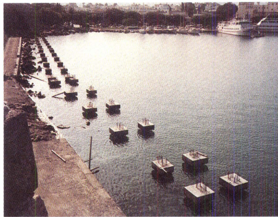
Ανακρηπίδωση Ανατολικής πλευράς λιμένα Κω
