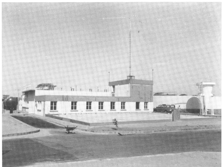
Usine ICS à Taïba
