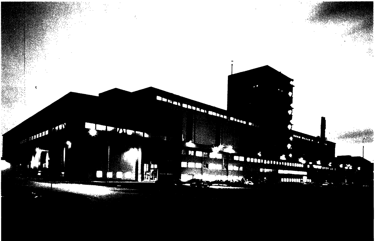
Bremer Galvanisierungs GmbH — hot dip galvanizing plant
