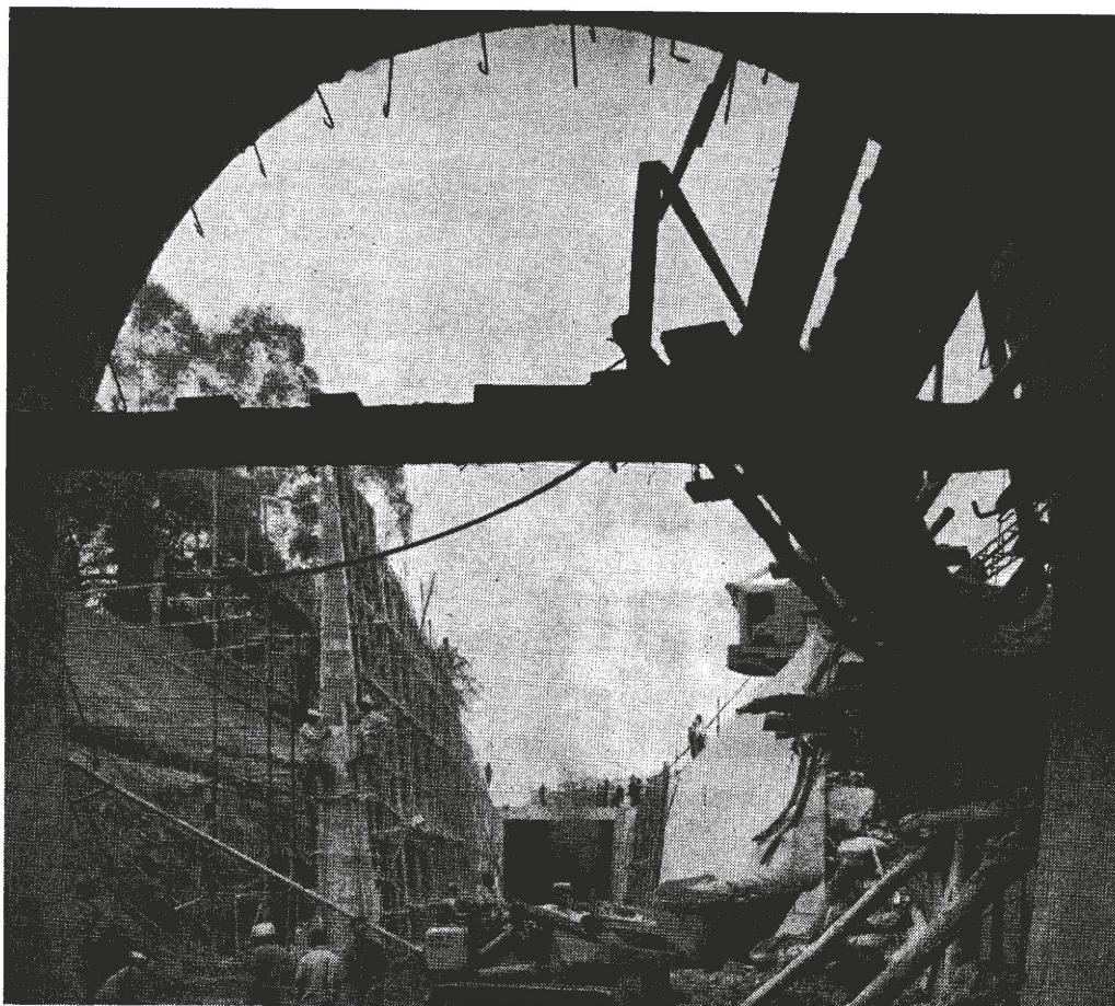
Le tunnel est percé. Le Transcamerounais peut s'élancer vers le nord.
