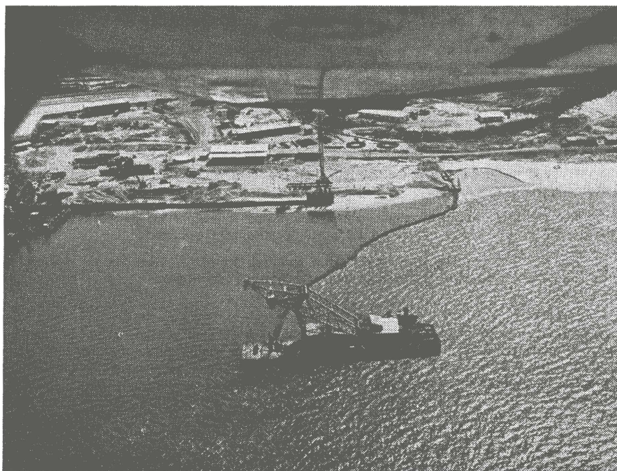
Ponton de dragage avec tuyau de refoulement de sable.
