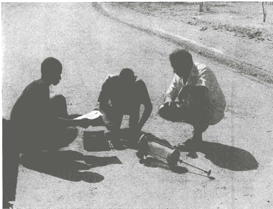
Compaction d'une route
