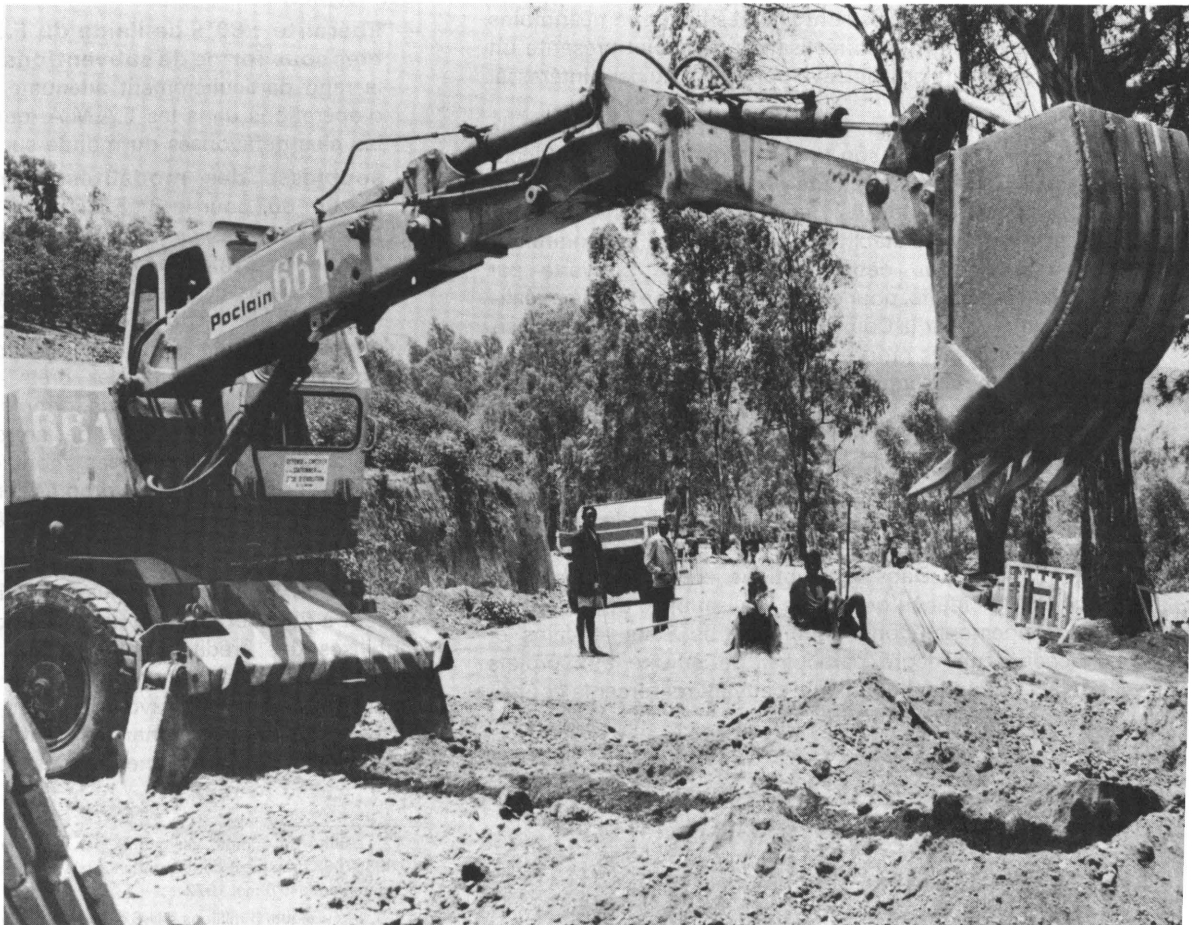
Construction de la route Muramvya-Gitega au Burundi.
