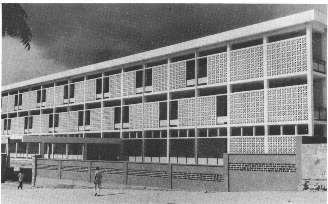
Ecole secondaire de Mogadiscio, première tranche, bâtiment « classes » : vue de l'entrée du complexe.
