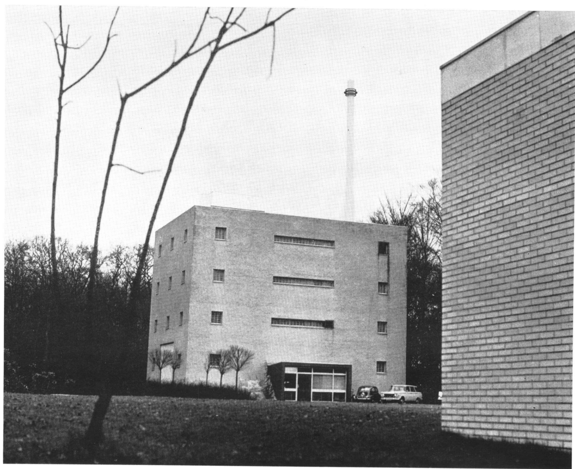
RÉACTEUR BARN (BIOLOGICAL AGRICULTURAL REACTOR NETHERLANDS) INSTITUT ITAL (WAGENINGEN)
