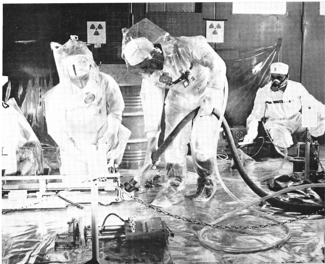
DÉCONTAMINATION DU RÉACTEUR ISPRA I
