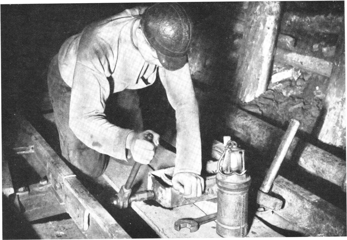
Apprentissage de travaux mécaniques dans un quartier-école
