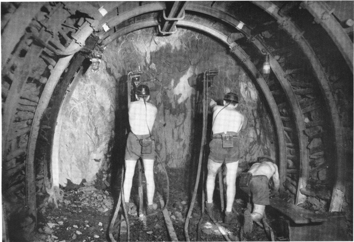
Creusement au rocher dans un quartier-école des Charbonnages de Monceau-Fontaine
