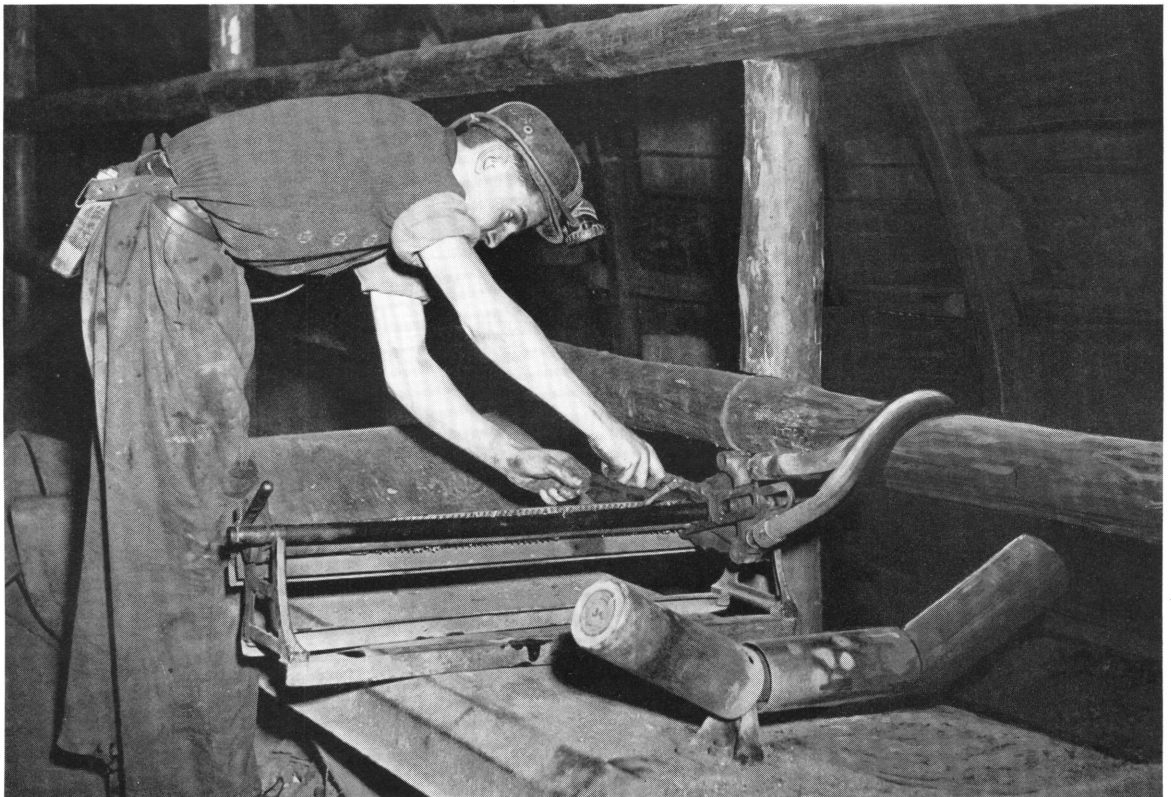
Raccordement de bande convoyeuse dans une galerie d'apprentissage à Maybach
