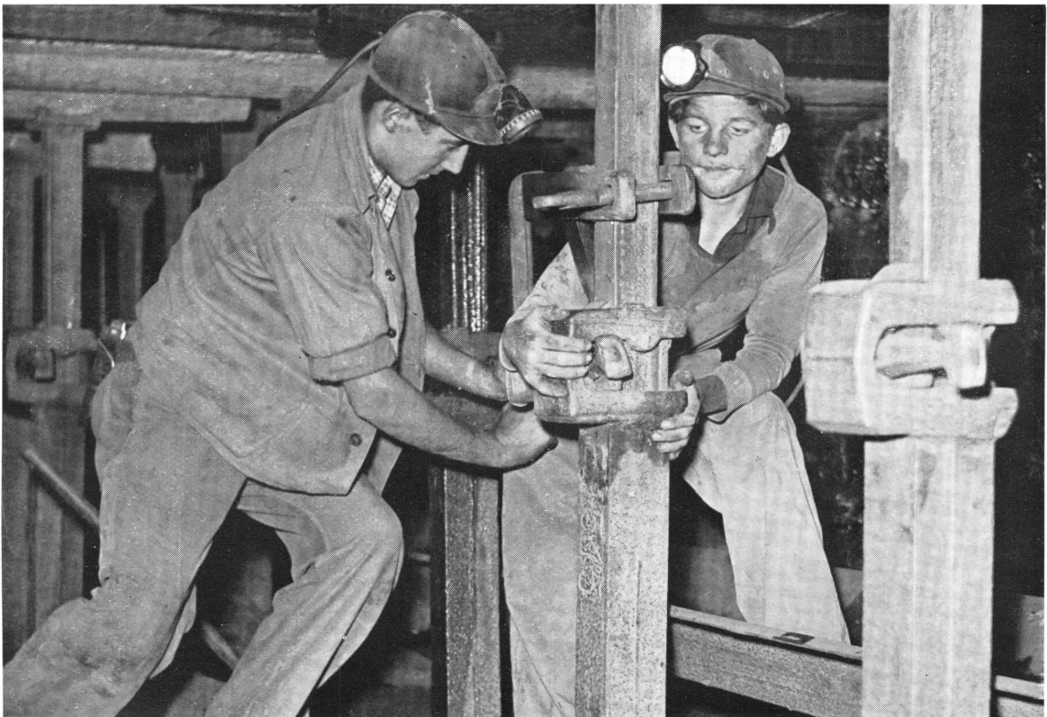
Mise en place d'un étauçon par un apprenti
