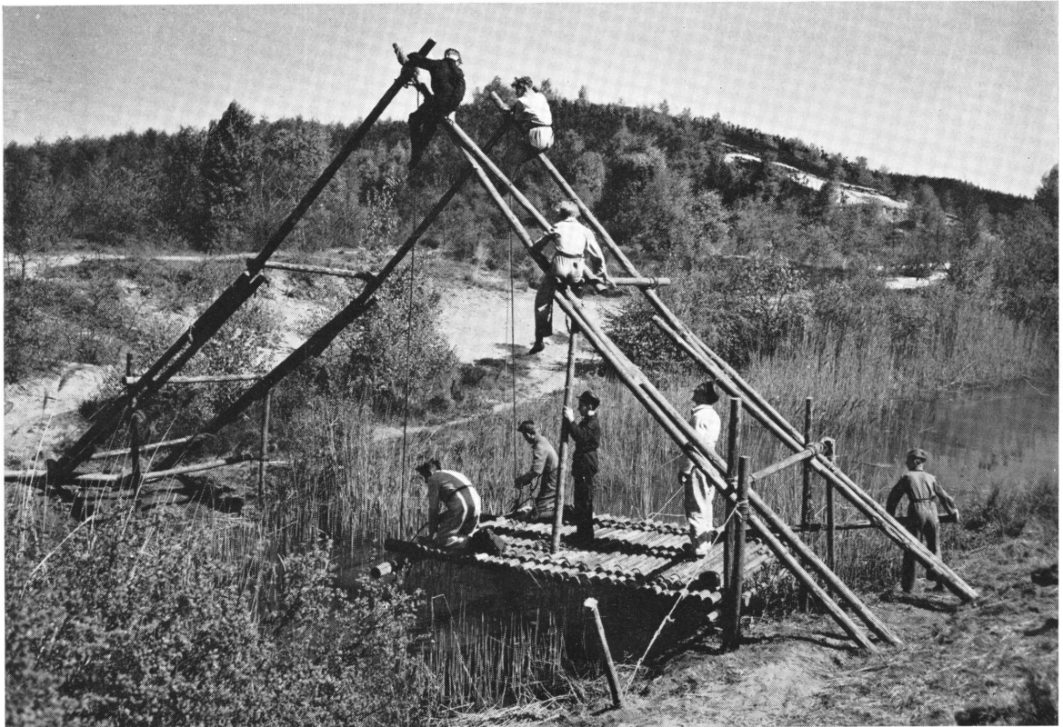
Construction d'un pont (exercice de scoutisme)
