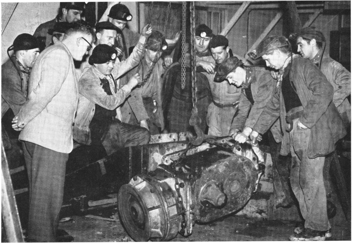
Démontage et étude d'engins du fond à la section de mécaniciens-ajusteurs de l'Ecole du charbonnage de Houthalen
