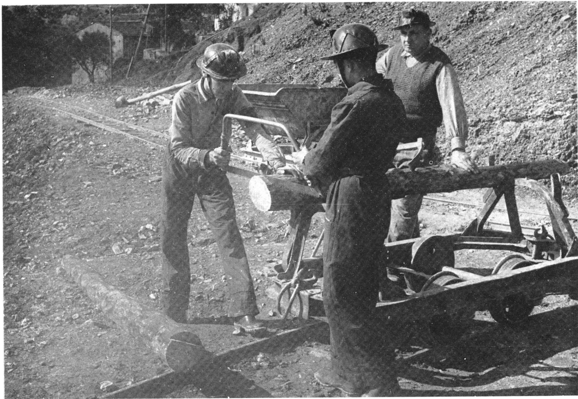
Confection d'un cadre de soutènement de galerie dans l'école professionnelle des mines de fer de Rio Marina (île d'Elbe)
