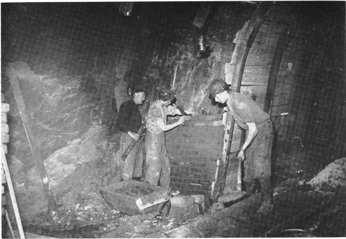
Apprentis de la 3 e année avec leur chef-piqueur occupés à des travaux de maçonnerie au fond dans une mine de la Erzbergbau Salzgitter AG
