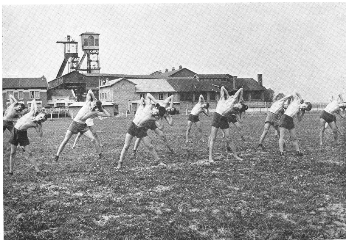
Séance d'éducation physique des apprentis de la mine de Moineville (au fond: le puits II en construction)
