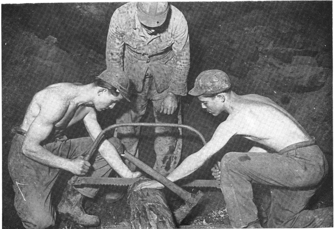
Apprentis de 2 e année confectionnant sous la conduite d'un chef-piqueur un cadre entaillé dans une mine de la Erzbergbau Salzgitter AG
