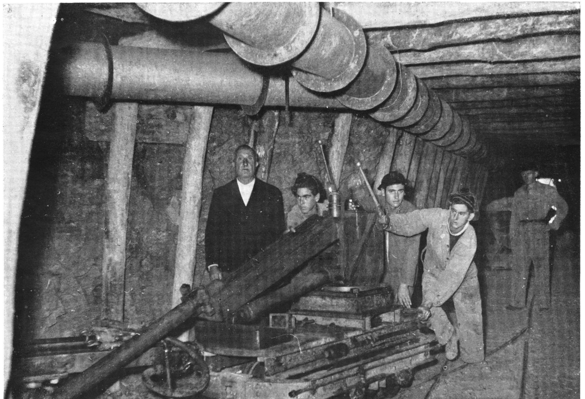
Préparatifs pour la foration avec perforatrice montée sur « Jumbo » dans l'école professionnelle des mines de fer de Rio Marina (île d'Elbe)
