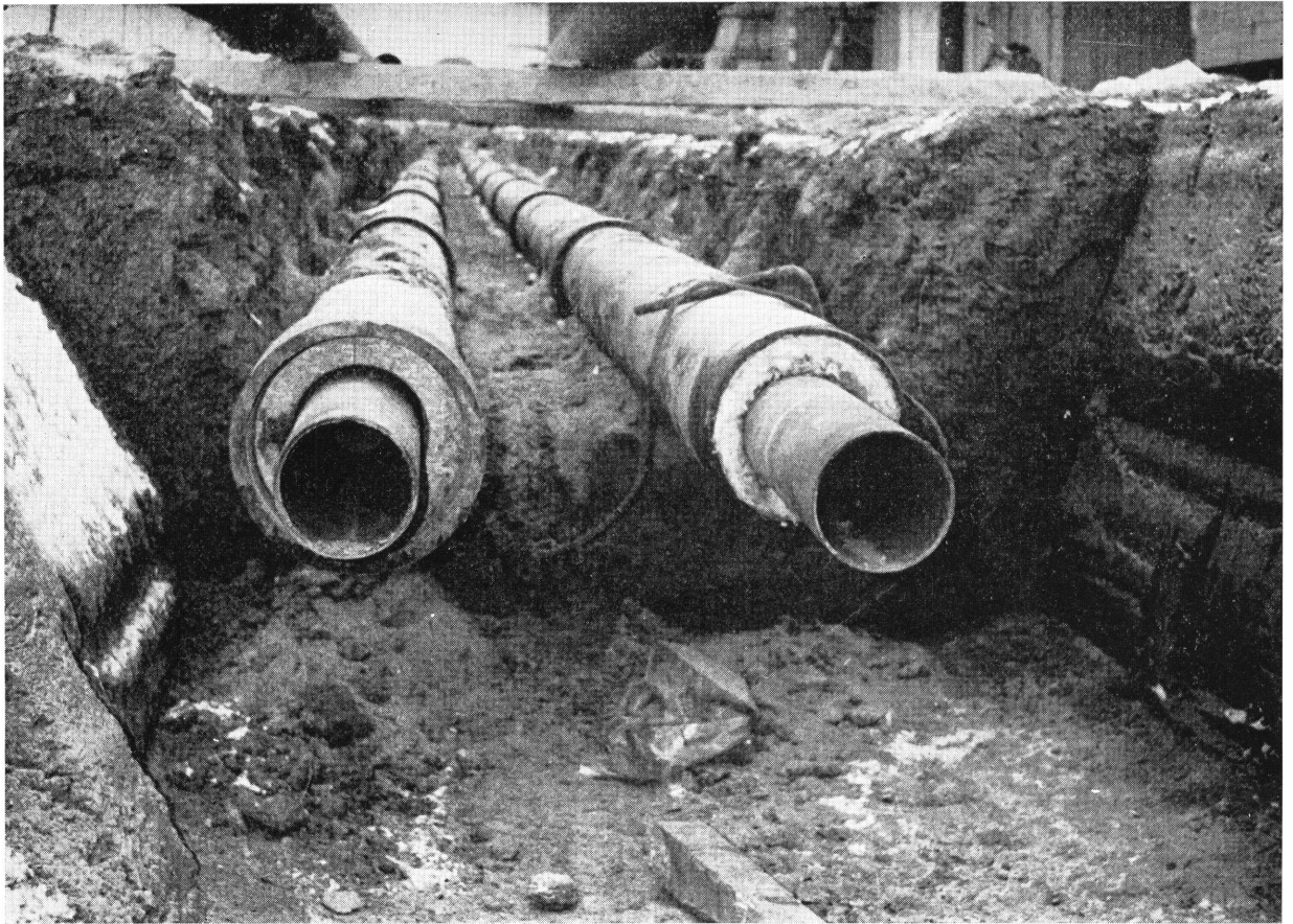
En construction la conduite principale du chauffage urbain
