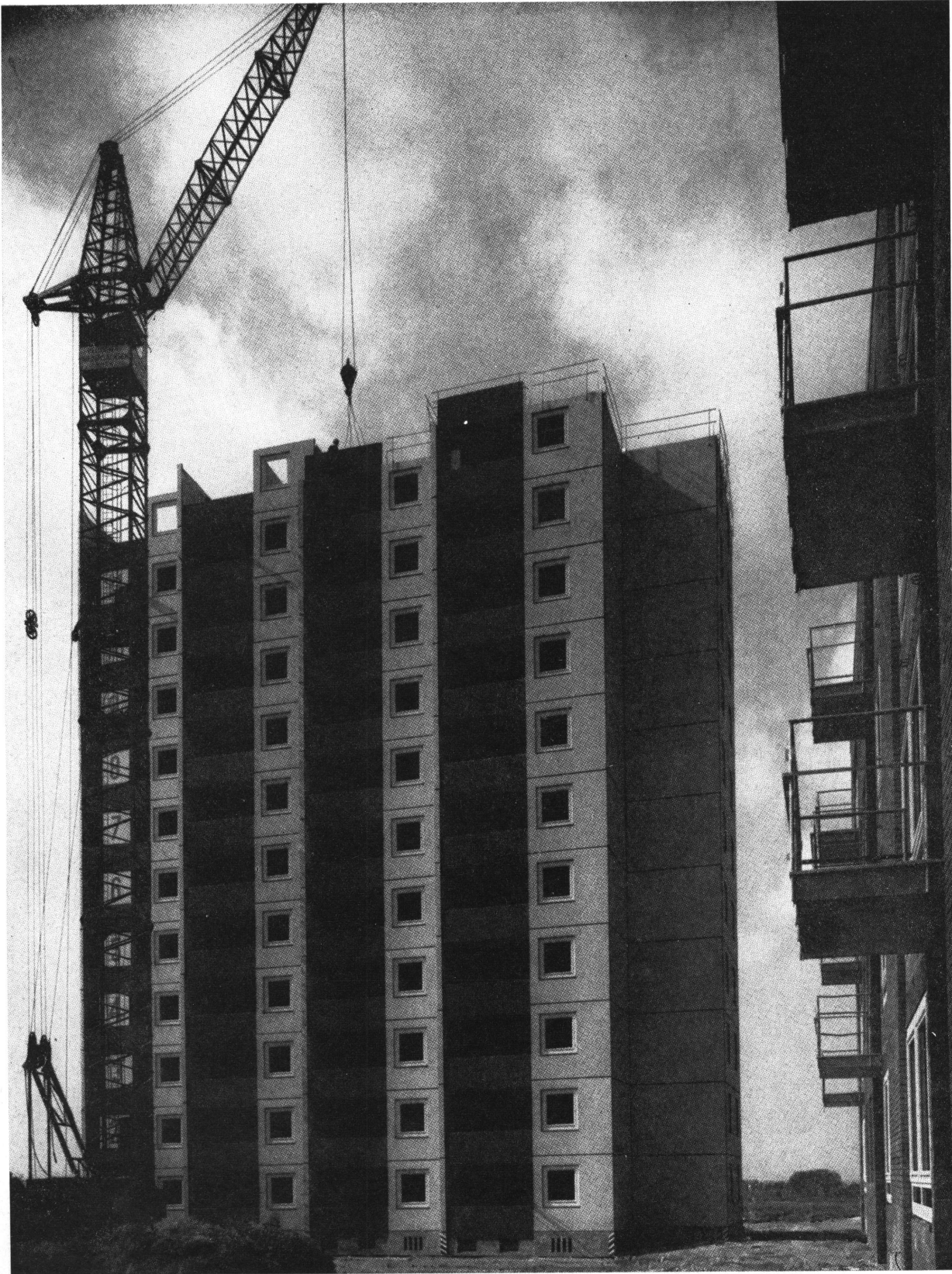
Bâtiment du type C XII en construction
