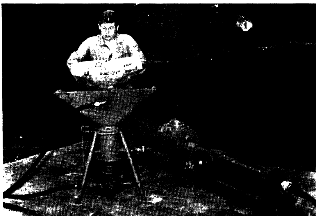
Vue d'ensemble de l'installation de mélange et de pompe
