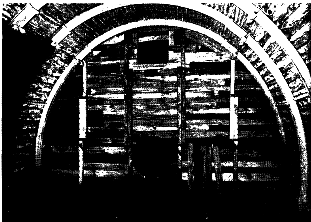
Cloisonnage pour barrage en plâtre à injection hydromécanique
