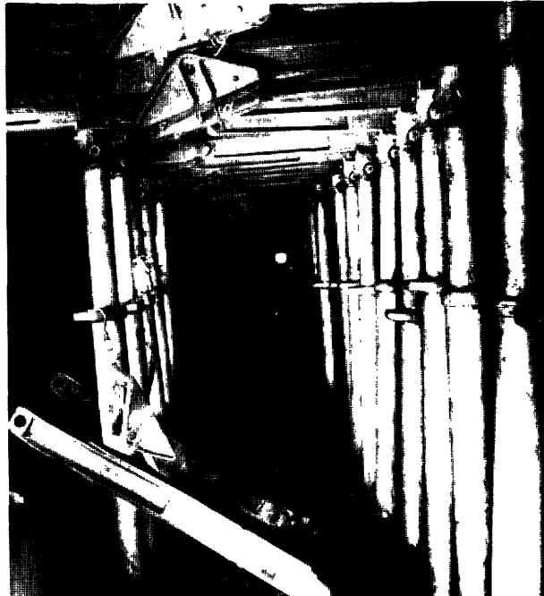
Fig. 1 - Etançons hydrauliques - Klöckner-Ferromatik étançons hydrauliques isolés des types S 41/125 et S 41/140 dans les 95 m supérieurs. Le charbon est abattu à l'aide d'un rabot adaptable de la
