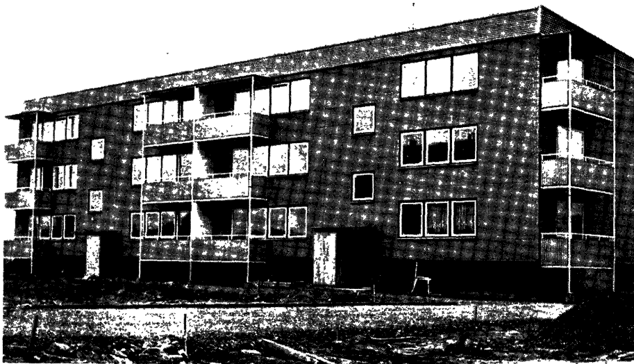
Un des bâtiments – Système «Hoesch»
