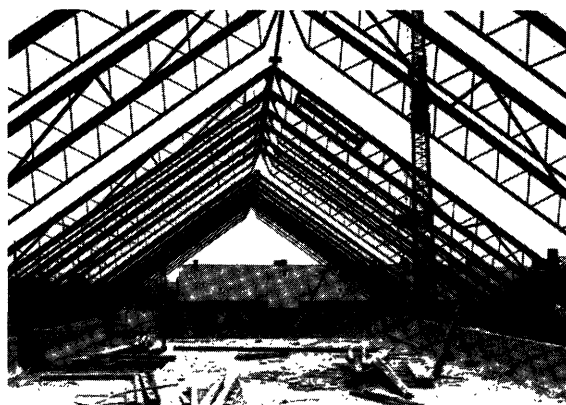
Photo 8 Essen-Frintrop Espace libre sous les fermes en acier
