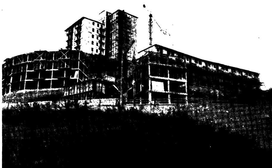
Vue du chantier
