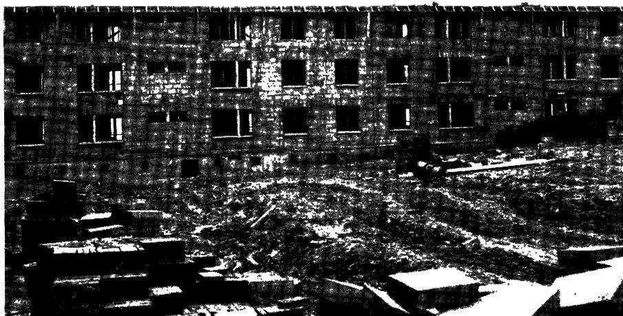
Un des bâtiments en exécution
