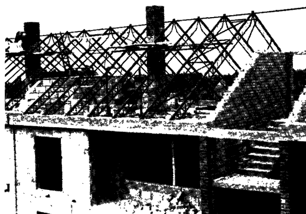
Charpente de toiture en acier
