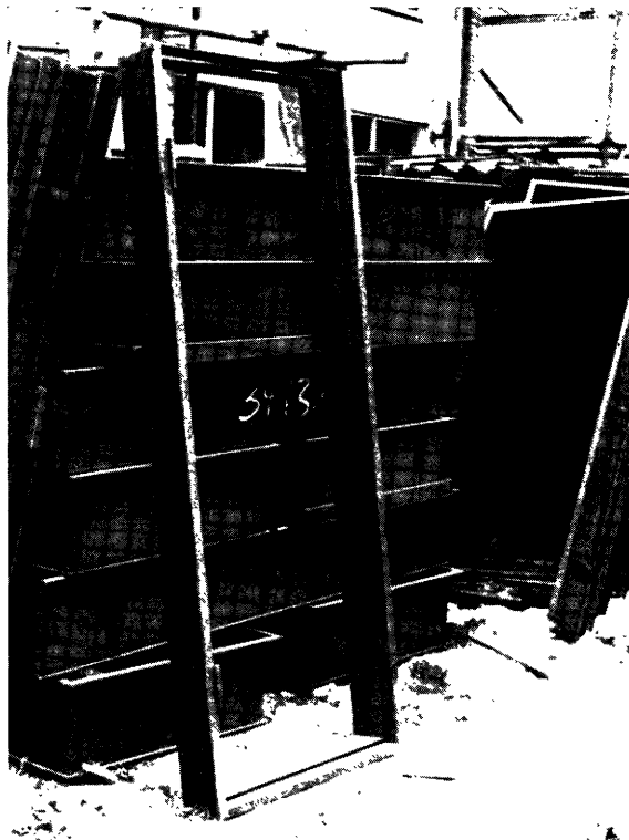
Photo 1 Essen-Frintrop Huisseries en acier entreposées sur le chantier avant montage
