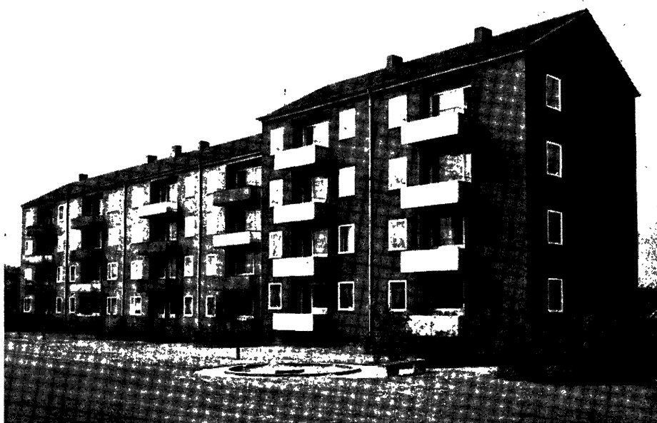
Un des bâtiments
