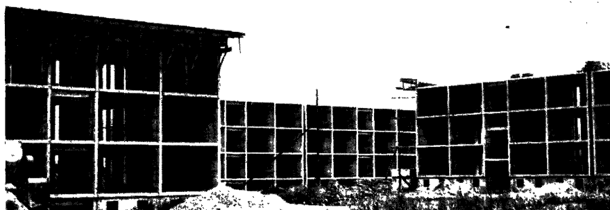
Vue d'ensemble de diverses unités types avant la pose des murs-rideaux
