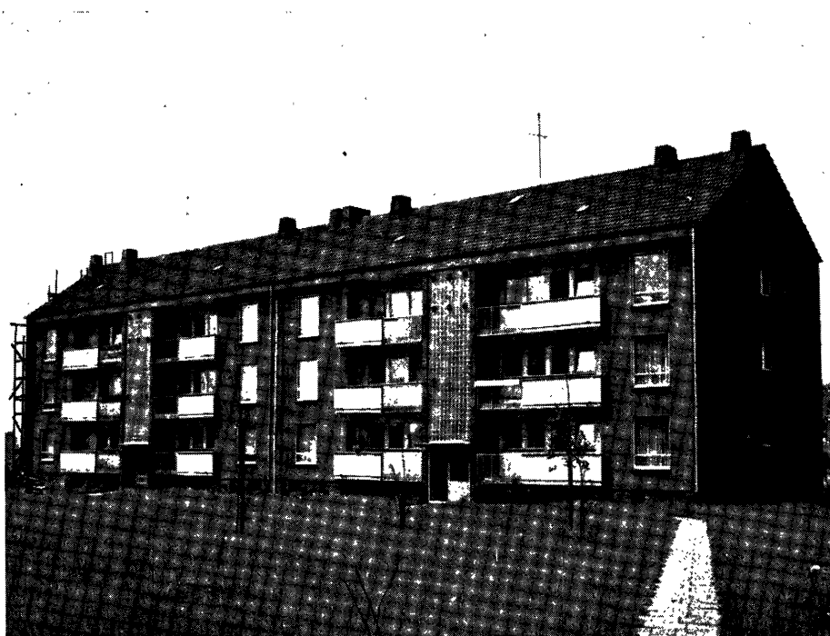
Vue d'un bâtiment
