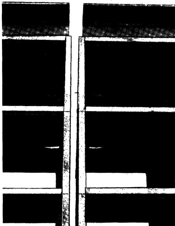
Vue en détail du joint de dilatation. Ce joint est destiné à compenser les mouvements provoqués par les affaissements éventuels du terrain.
