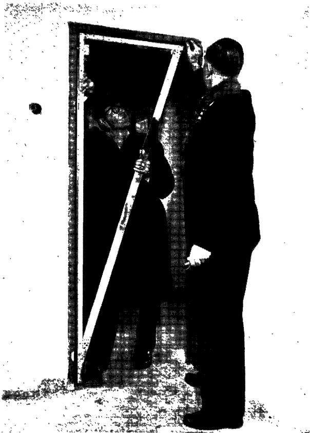
Photo 3, mesure de l'équerrage de l'huisserie
