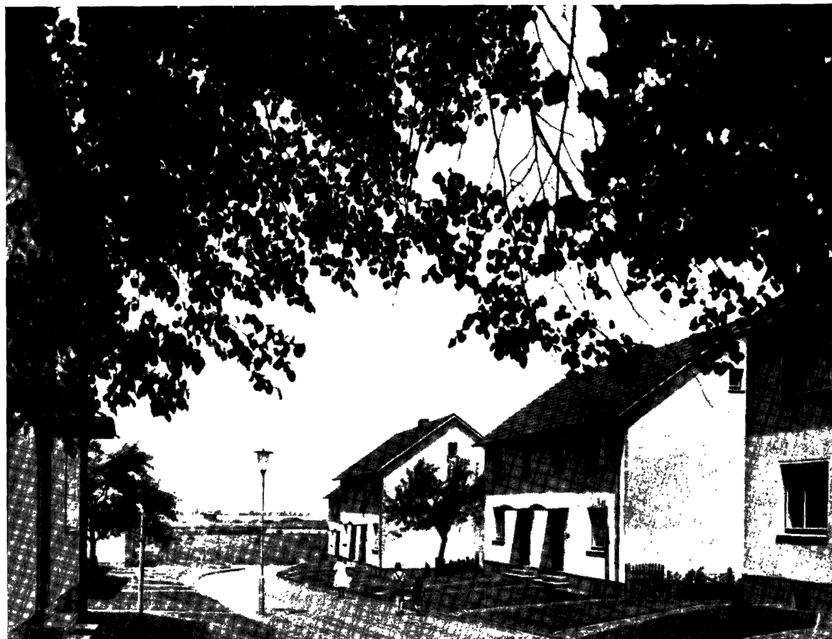
ALLEMAGNE Chantier de Aachen-Siersdorf (4) - Page 87
