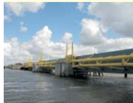
Emssperrwerk flood barrier
