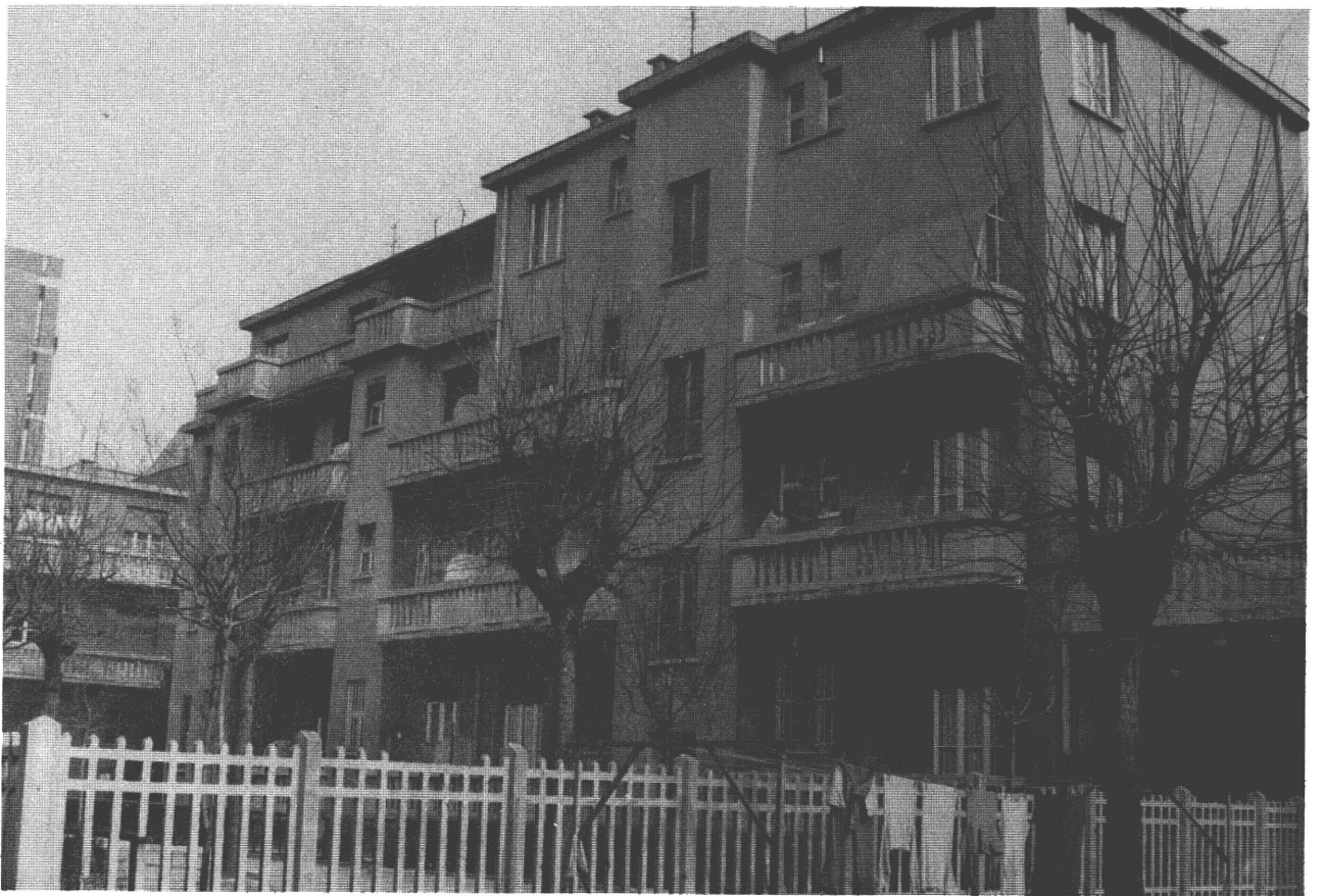
SESTO SAN GIOVANNI – Immeuble du Programme Expérimental à moderniser – Vue sur cour intérieure
