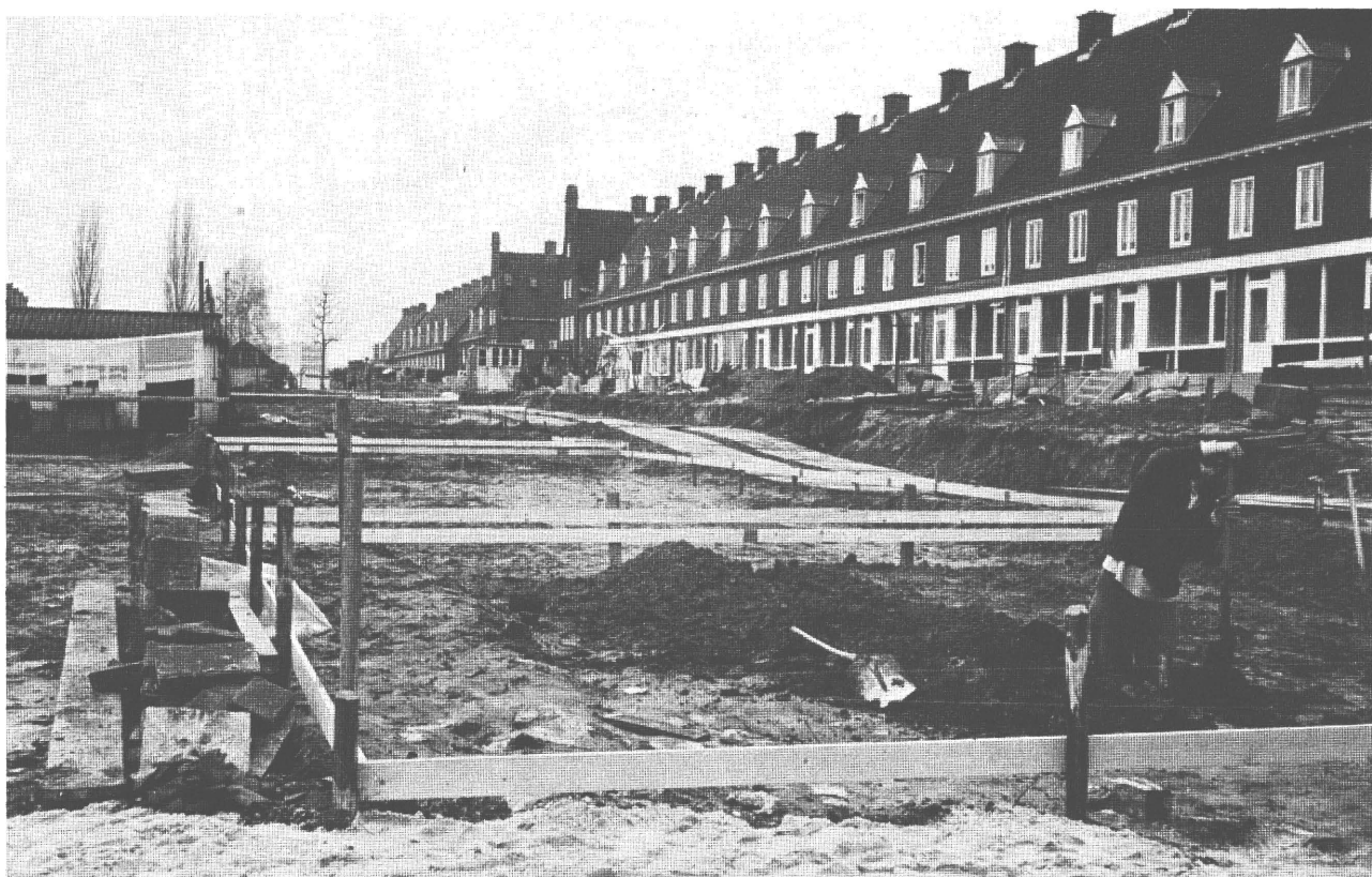
HEERLEN — Au premier plan: implantation de garages — Au second plan: chemin de grue desservant le chantier d'agrandissement des séjours et de création de terrasses
