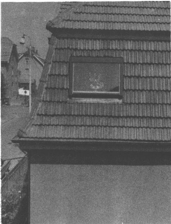
HAGONDANGE – Chassis préfabriqué ouvrant éclairant une chambre mansardée
