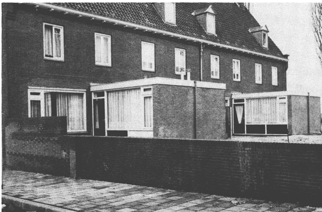
HEERLEN – Les nouvelles cuisines ajoutées au corps principal du bâtiment (façades préfabriquées)
