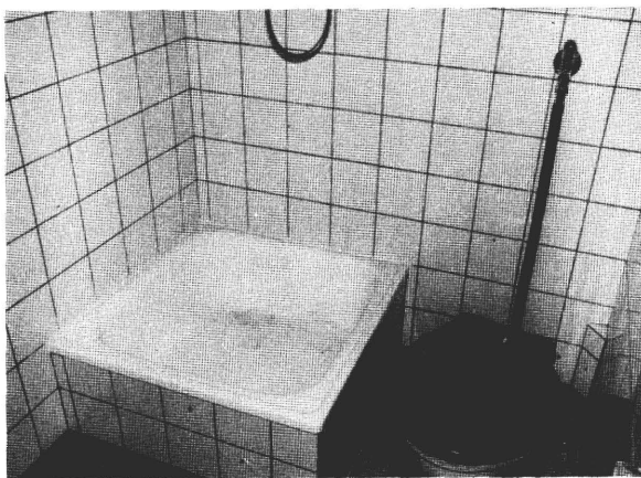
HEERLEN – Nouvelle salle d'eau
