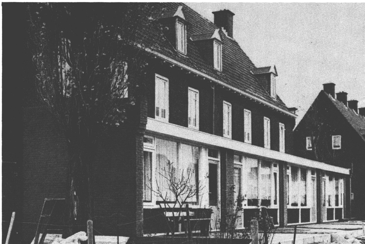
HEERLEN – Les nouveaux séjours et les terrasses les prolongeant (façades préfabriquées)
