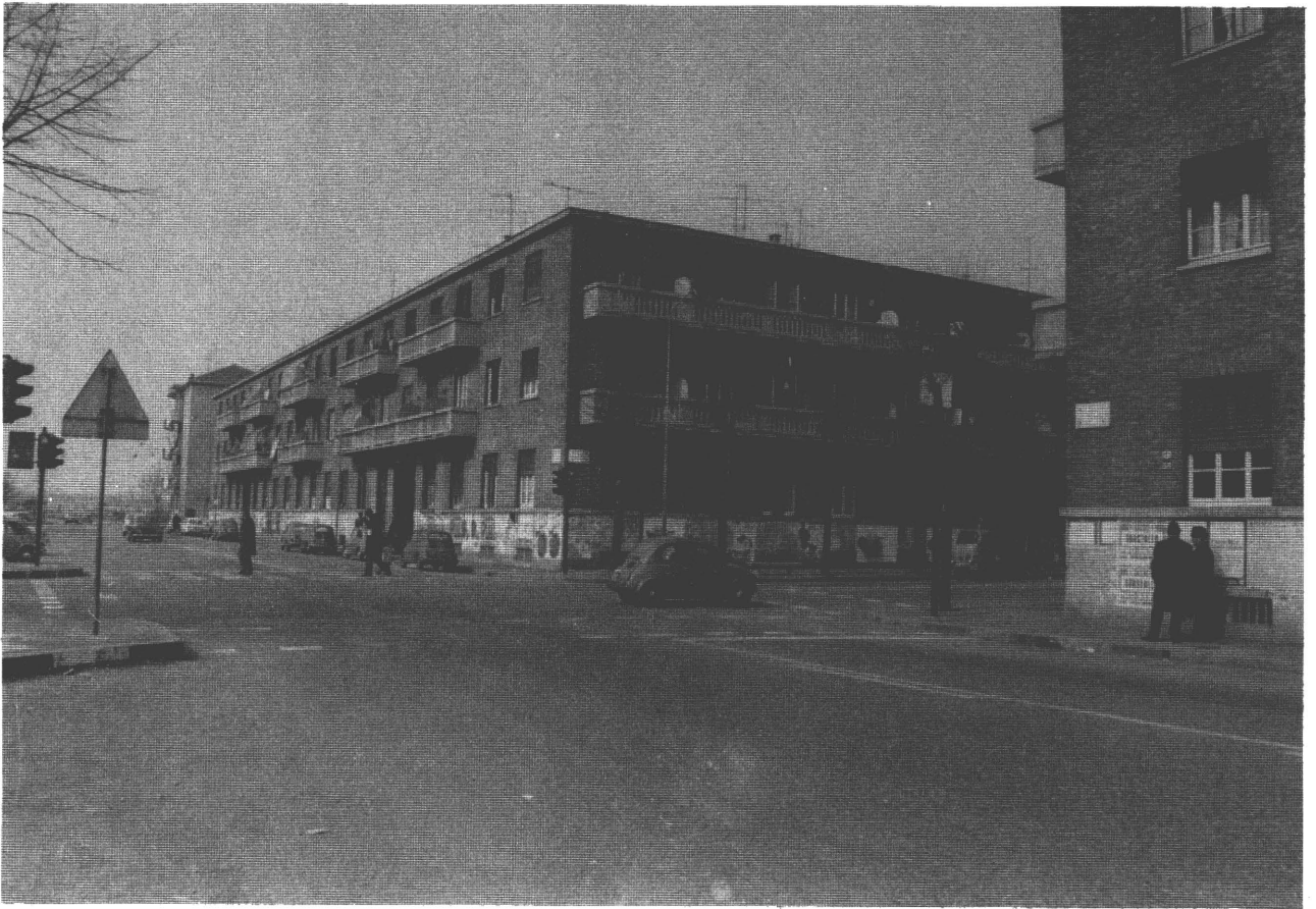
SESTO SAN GIOVANNI – Immeubles du Programme Expérimental à moderniser.
