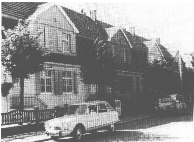
HAGONDANGE – Maisons en bande modernisées. (Les enduits et les peintures extérieures sont harmonisés par le coloriste conseil)
