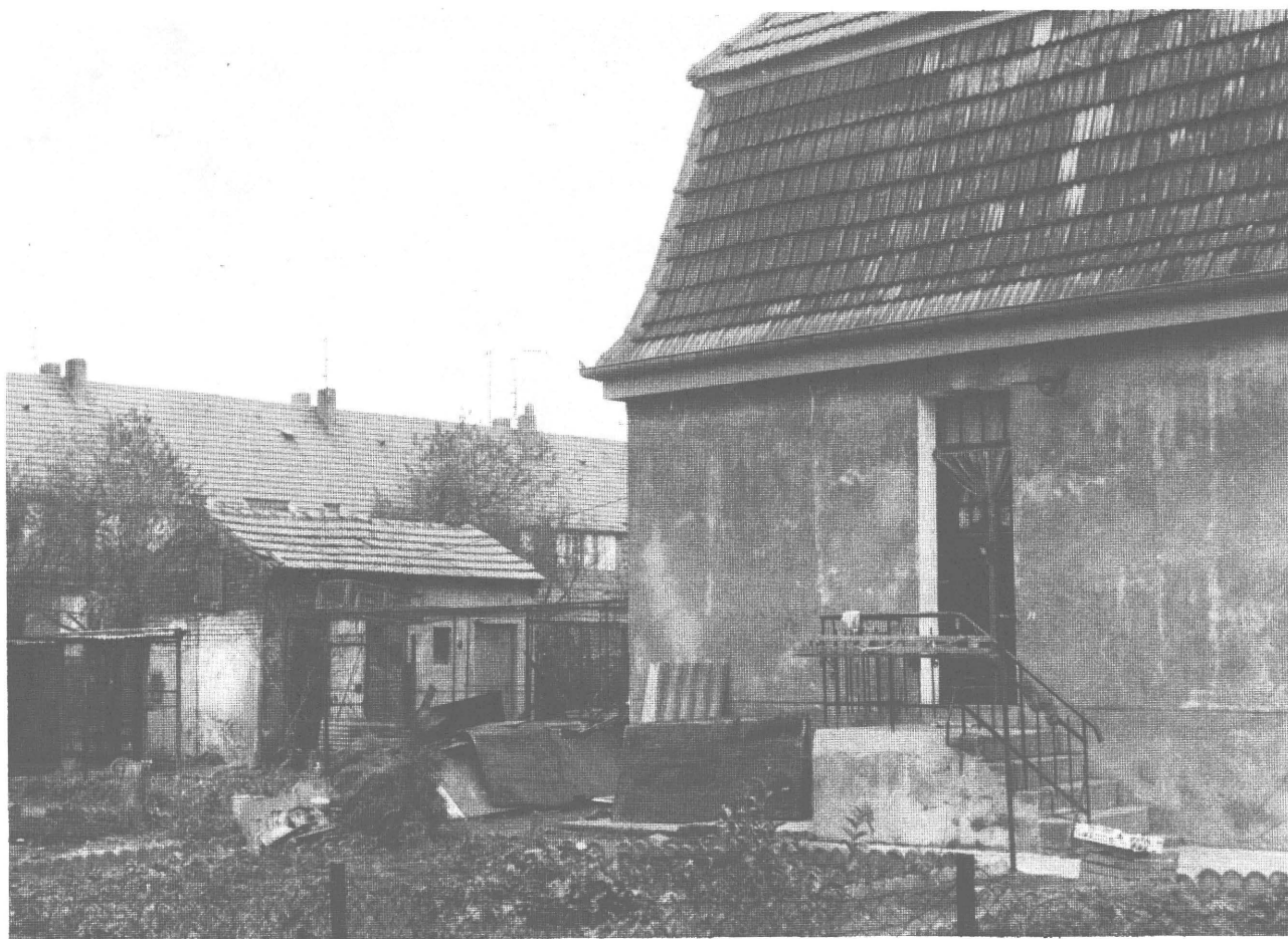
HAGONDANGE – Environnement des maisons avant modernisation ,
