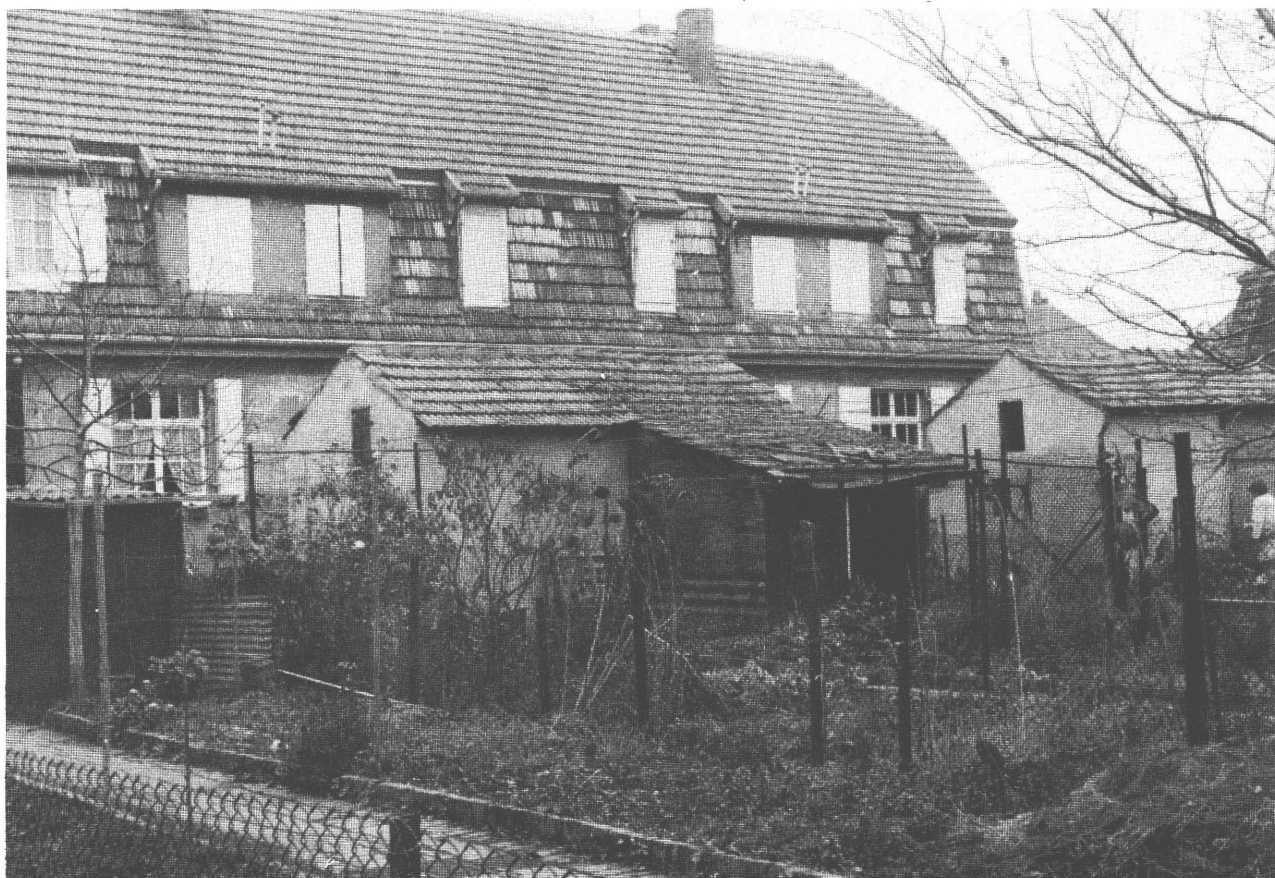
HAGONDANGE – Environnement des maisons avant modernisation
