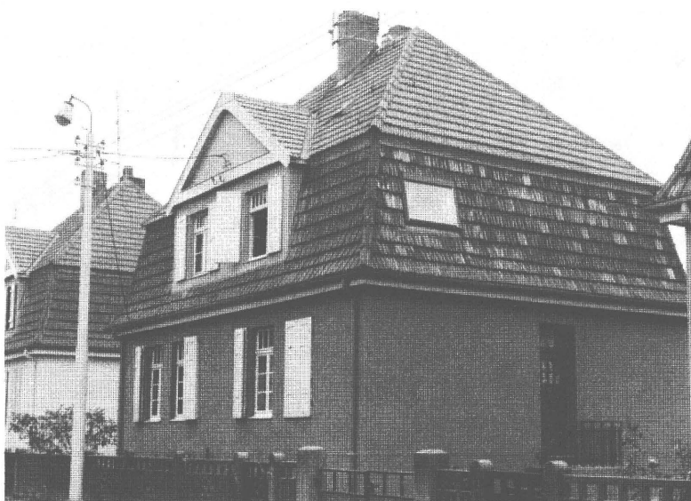
HAGONDANGE – Maison individuelle modernisée. (Remarquer le chassis préfabriqué ouvrant éclairant une chambre)
