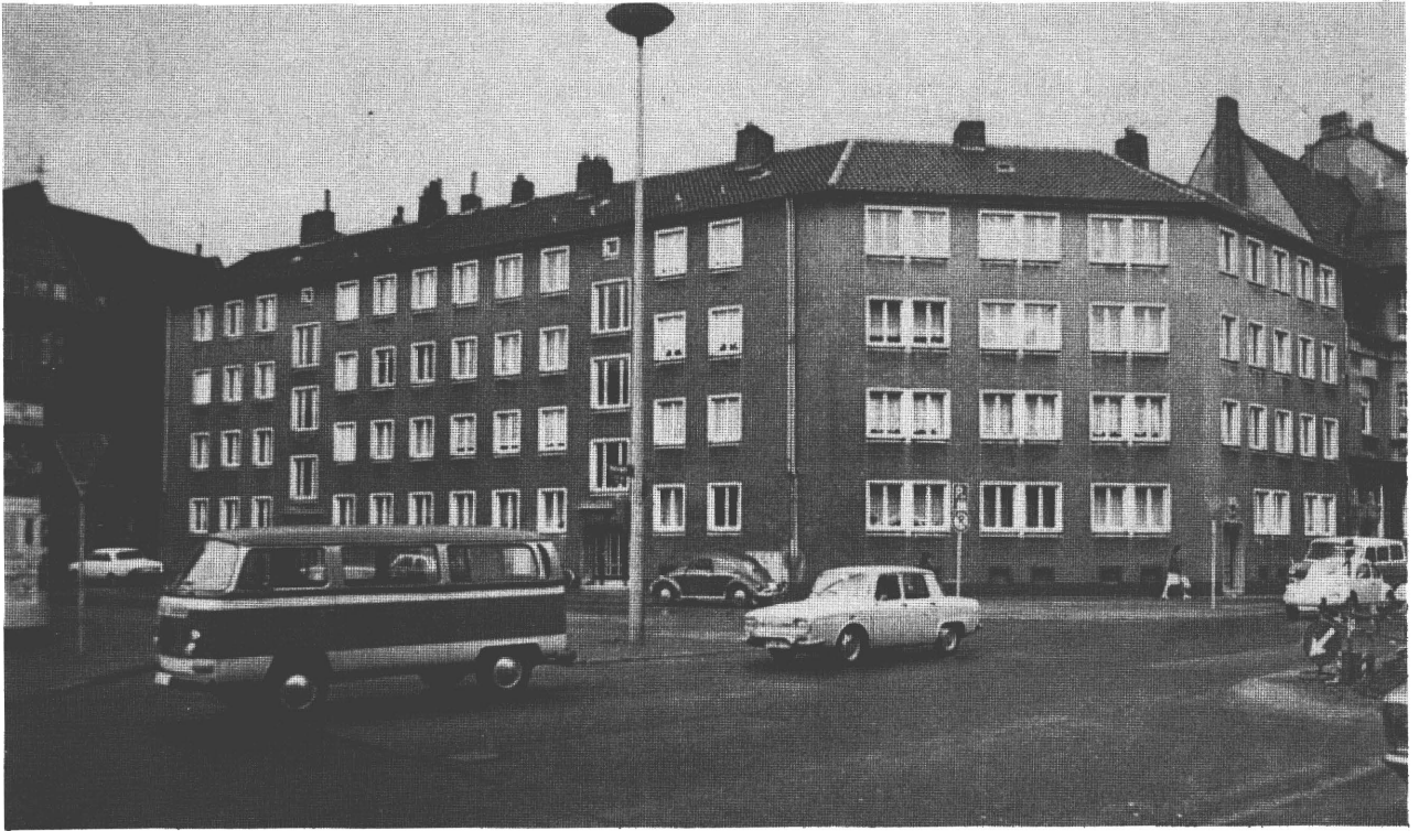
DORTMUND – Immeuble modernisé
