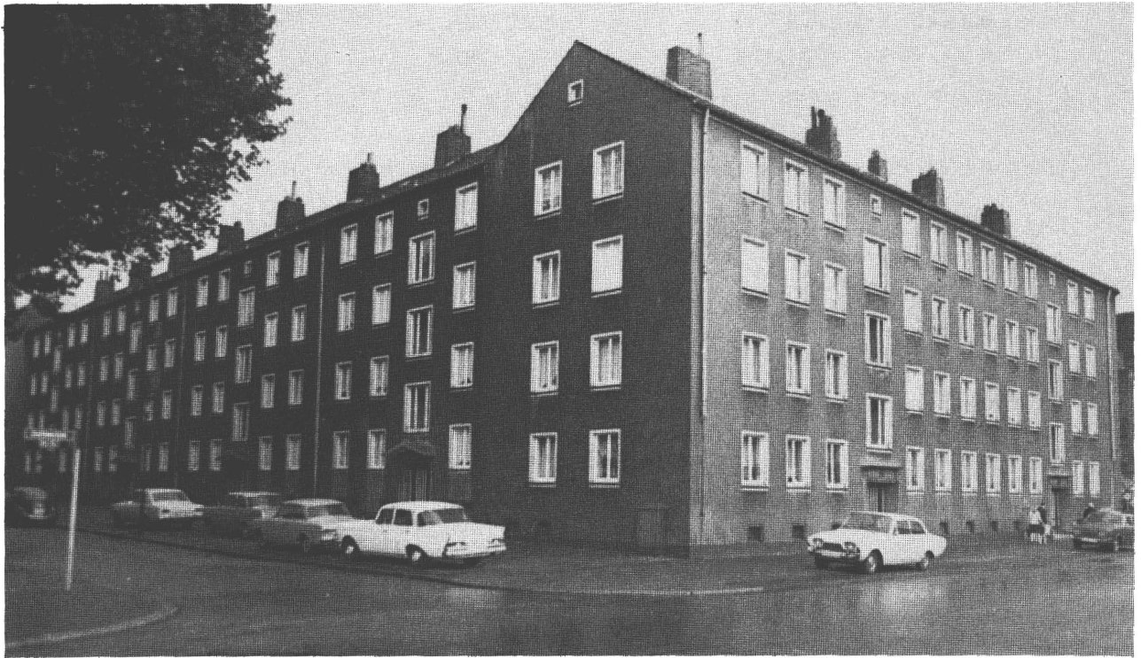
DORTMUND – Immeuble modernisé
