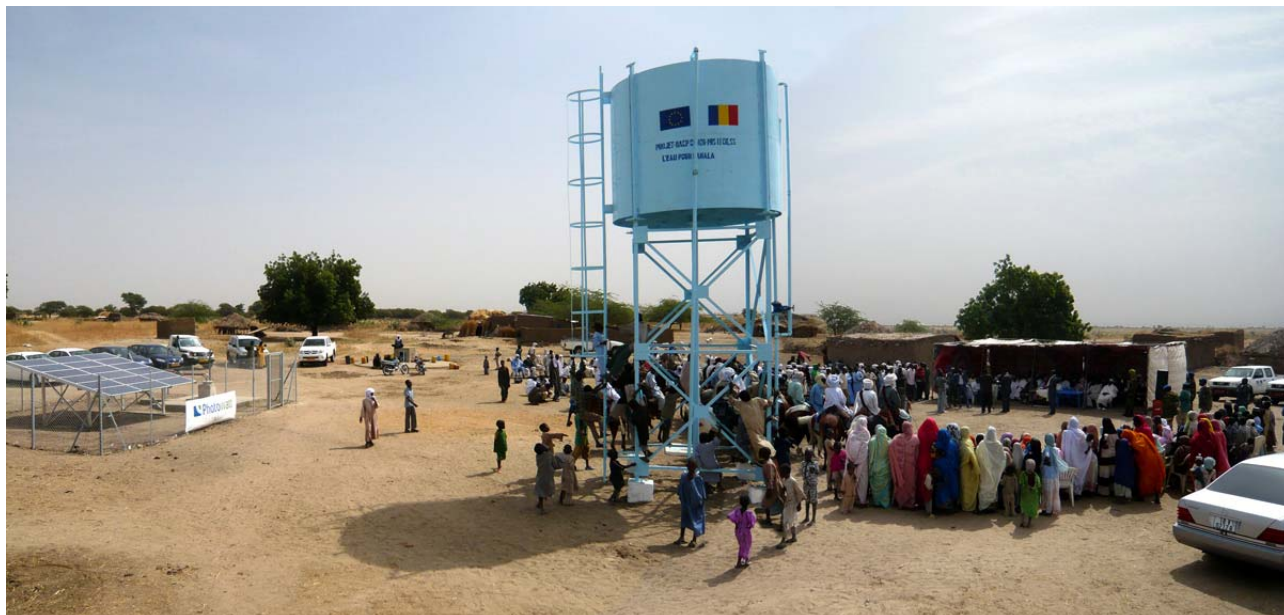
Inauguration Château d'eau de Naala - 23 Jan 08.
