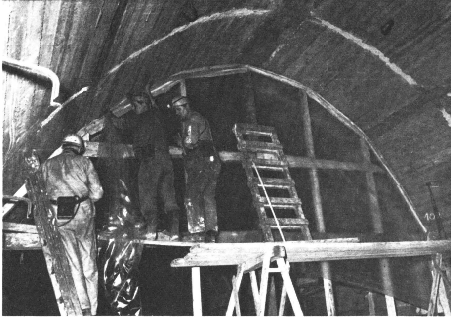
Fig. 3 : Travaux sur l'écran de la chambre à grisou
