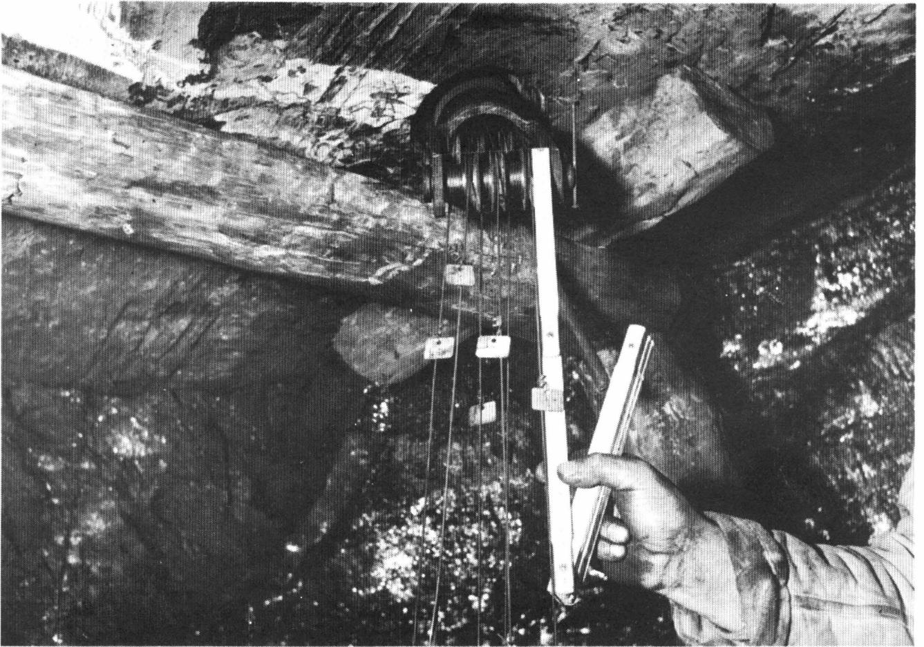
Abb. 6 Messung der Auflockerung an einem Bohrloch
