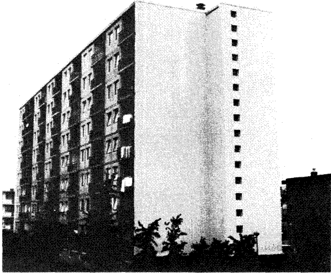
Fig. 23 : Holland : Amsterdam-Nieuwendam building
