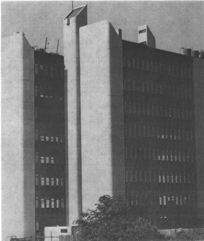
Fig. 2 Institut für Umweltschutz des Landes Baden-Württemberg, Karlsruhe. Water-filled outer columns in MSH 180 x 100 mm
