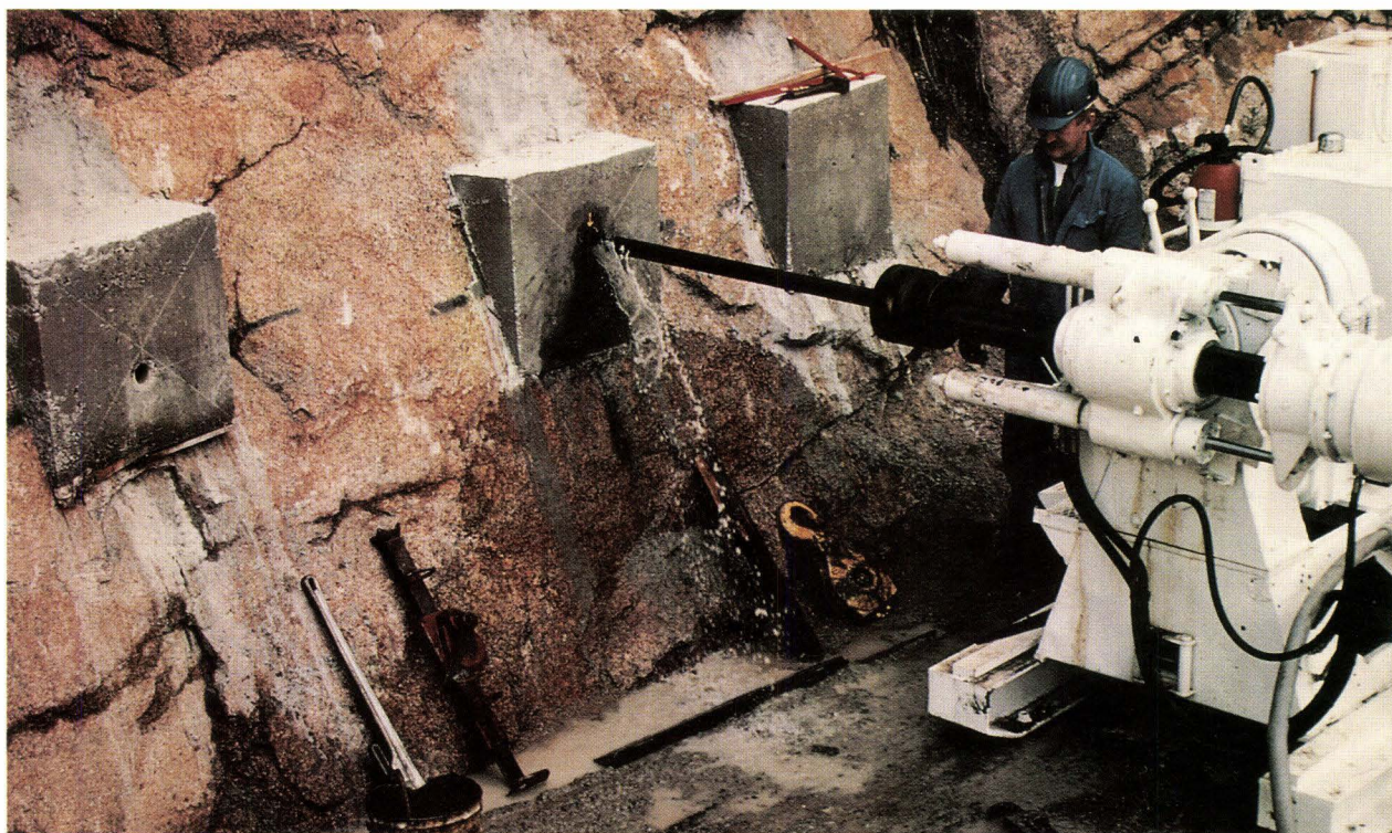
Figure 126 - Réalisation des forages en diamètre 56 mm
