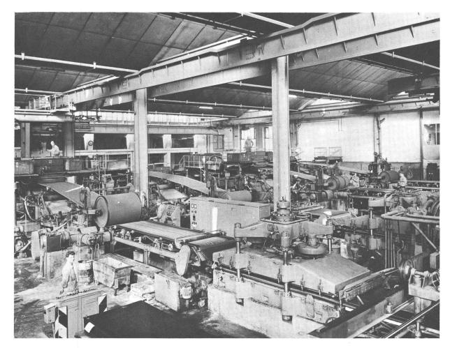
Fabrikationshalle mit 4 Asbestzement-Plattenmaschinen nach HATSCHEK  $\mbox{}^{\prime}$ Bild 1
