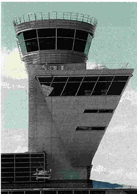
Vantaa Airport, Helsinki
